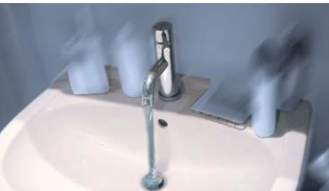
Contrôlez également la pression qui règne dans vos conduites d'eau. Si celle-ci est supérieure à 4 bars, installez un limiteur de pression (pour Virelles, la pression est normalement de 5 bars ; vous pouvez la vérifier pour votre habitation en téléphonant au service technique de la SWDE au 071/58 50 00).
